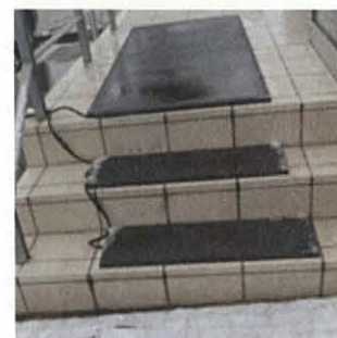
＜ヒートマットの設置例＞
